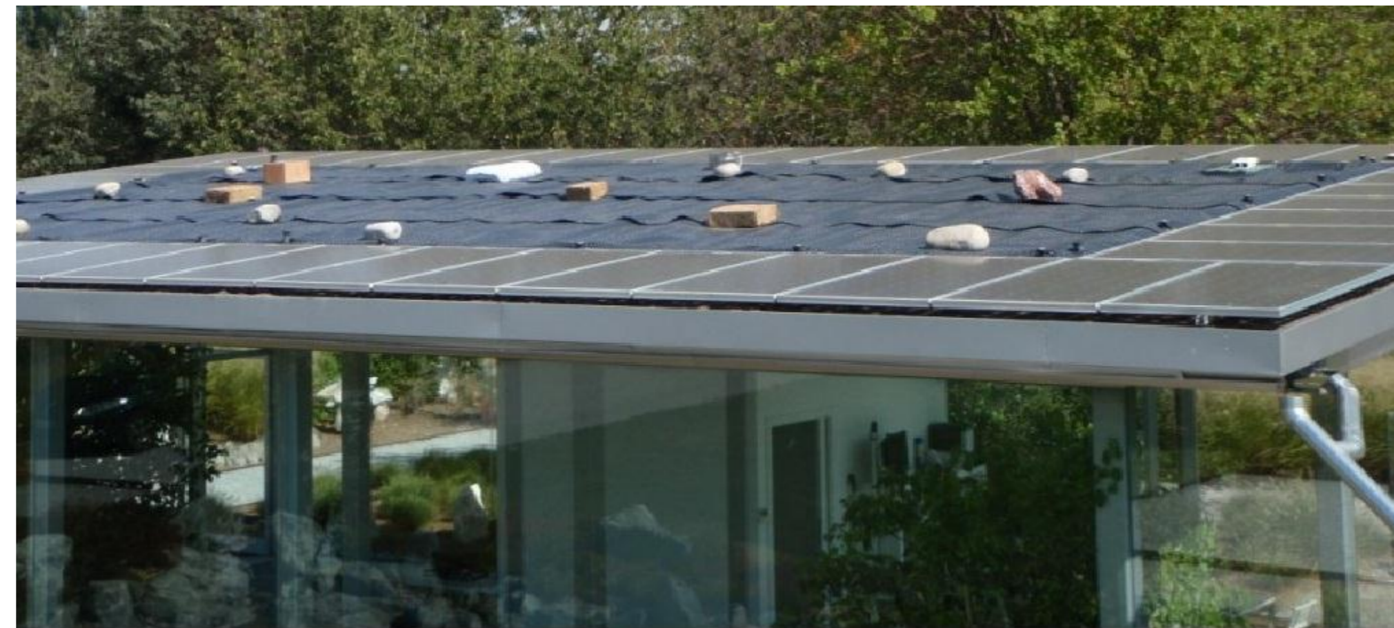
Guaina bituminosa nera posata in copertura.
