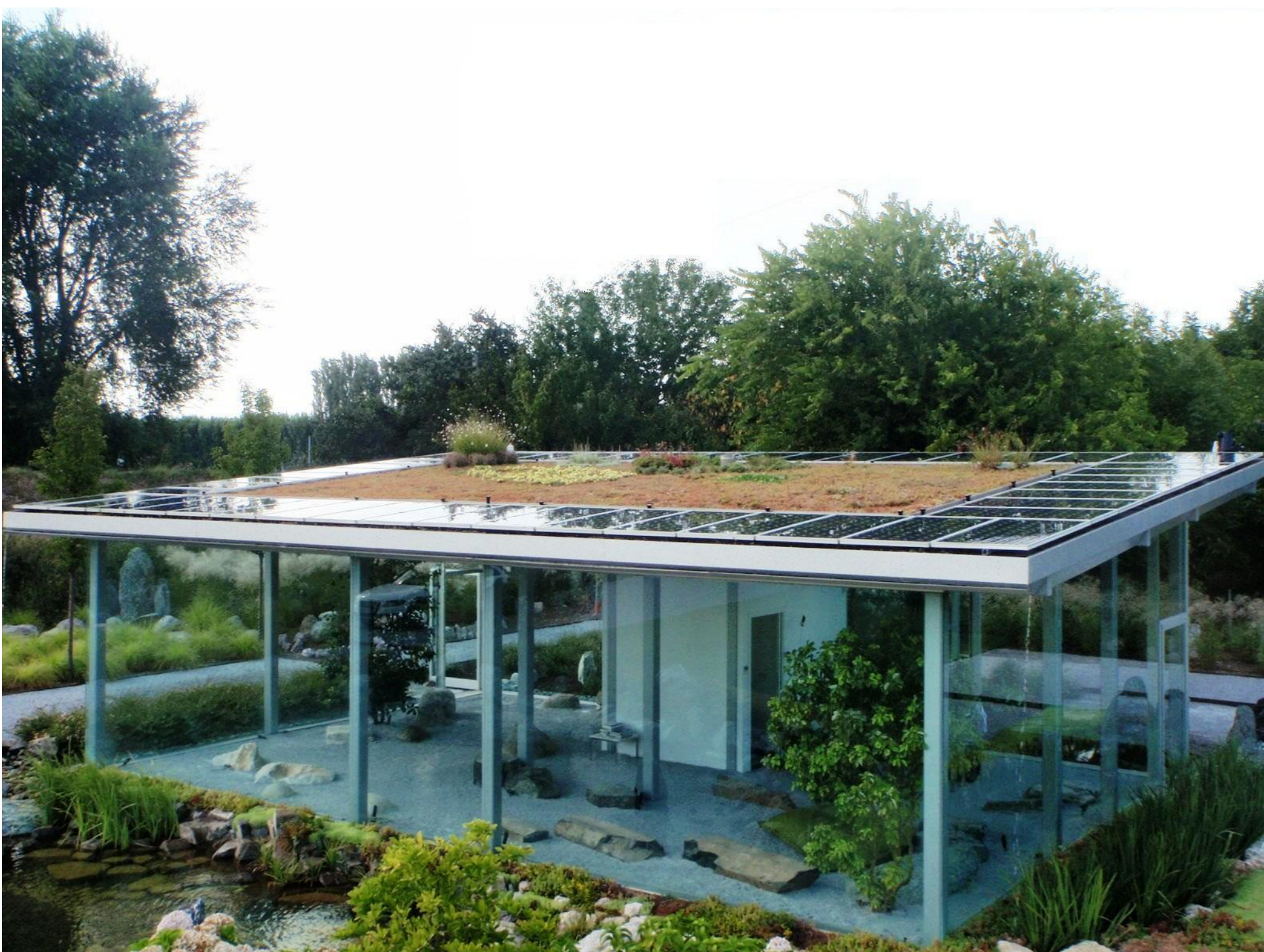
Prototipo GENERA: sistema integrato composto da impianto fotovoltaico, verde pensile e sistema di raffreddamento situato a Bologna.
