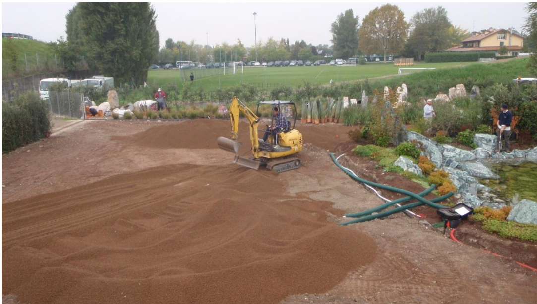
Figura 2-15: Posa dello strato di lapillo vulcanico LV 5/10 nel giardino filtrante.
