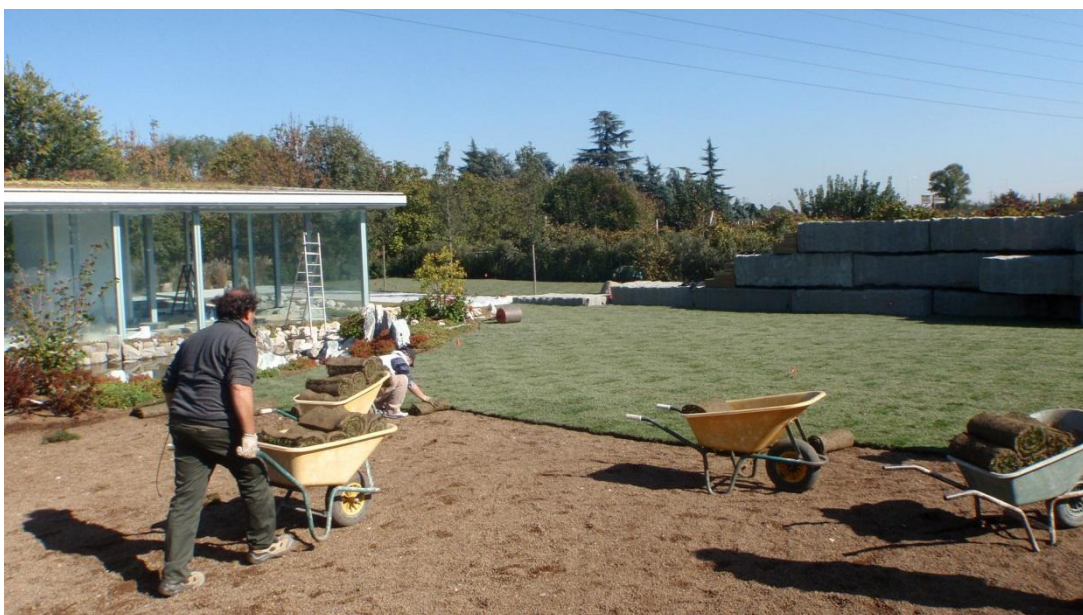
Figura 2-16: Posa del substrato erboso del giardino filtrante.
