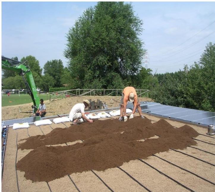
Figura 2-2: Posa del substrato colturale.
