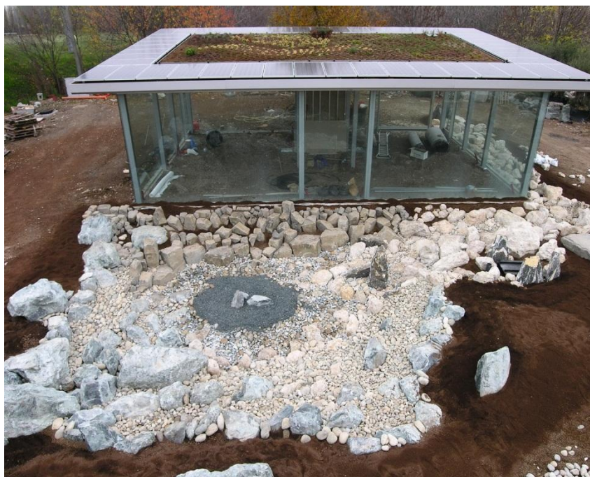
Figura 2-17: Biolago in fase di realizzazione.
