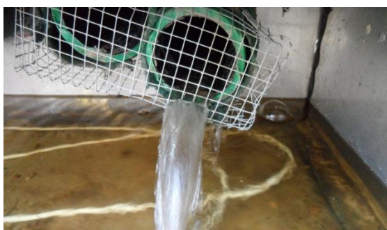
Figura 2-22: Vasca di raccolta acqua giardino
