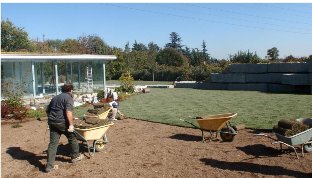
Figura 2-16: Posa del substrato erboso del giardino filtrante.
