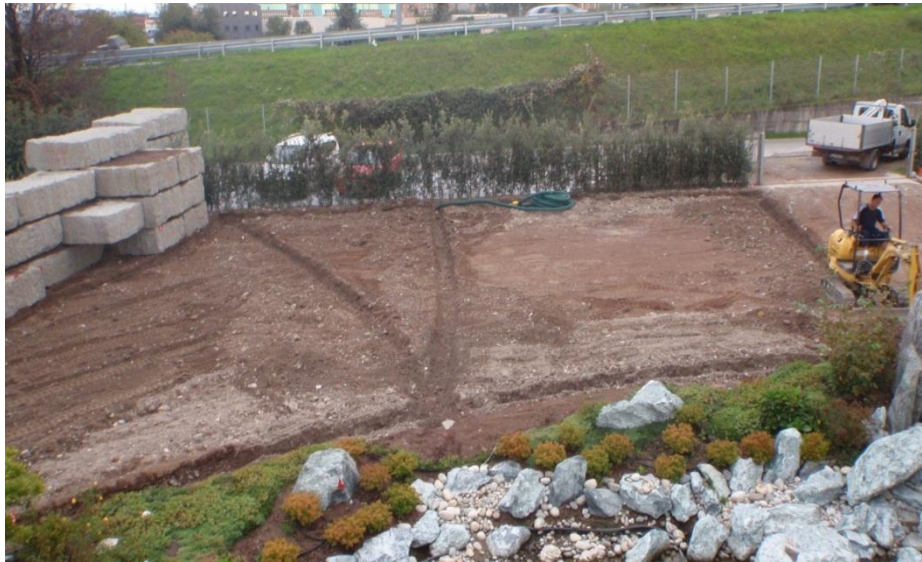
Figura 2-13: Scavi per la posa dei dreni del giardino filtrante.
