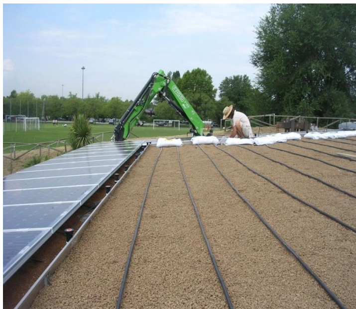
Figura 2-12: Copertura del prototipo GENERA. Posa dell'ala gocciolante della sub-irrigazione.
