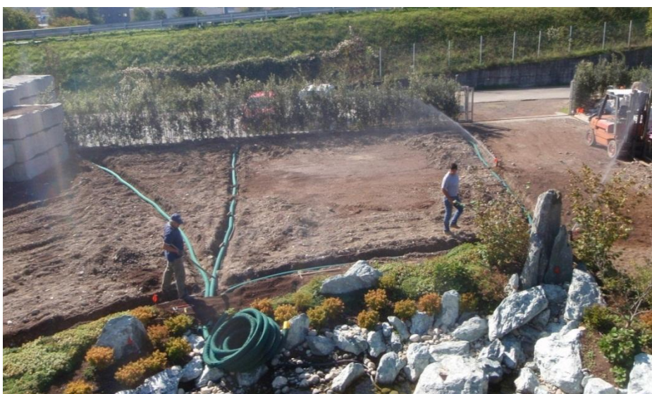
Figura 2-14: Posa dei dreni del giardino filtrante.
