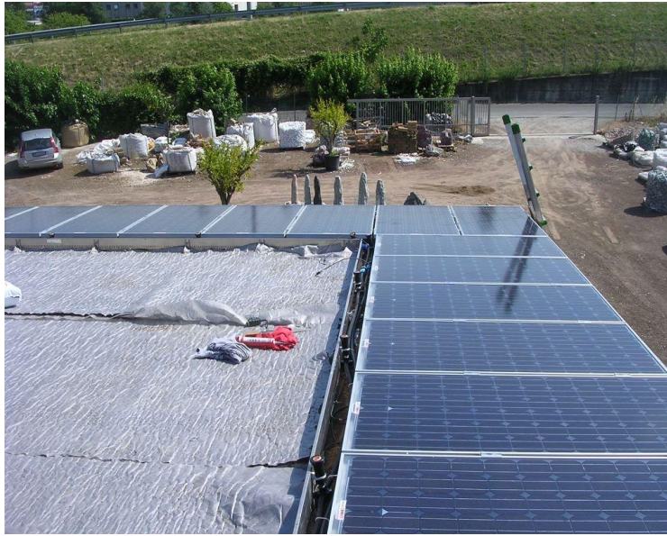
Figura 2-8: Copertura del Prototipo GENERA. Fase di montaggio dell'impianto fotovoltaico.
